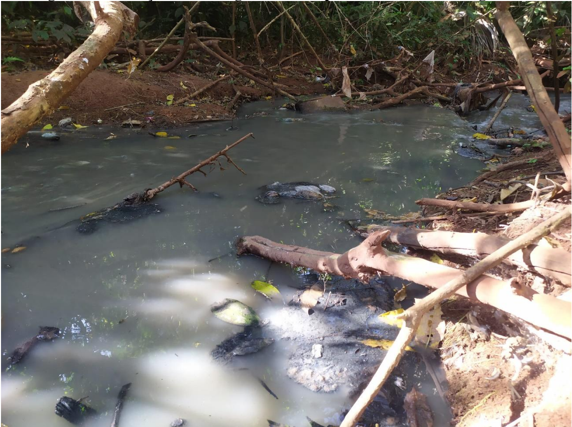
Figura 7.11 – Lançamento de esgoto sanitário por moradores no Córrego Buriti.
