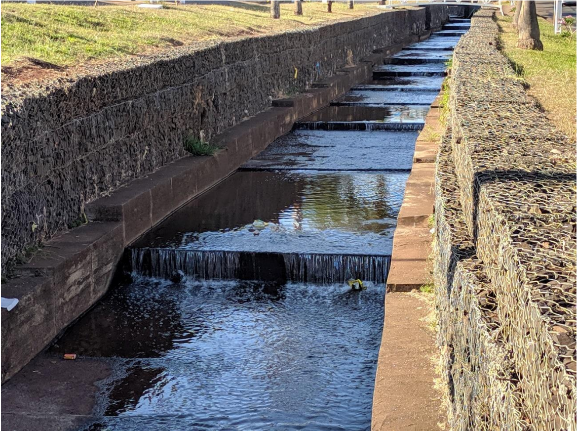
Figura 7.8 – Escadas de aeração no Córrego Barrinha.
